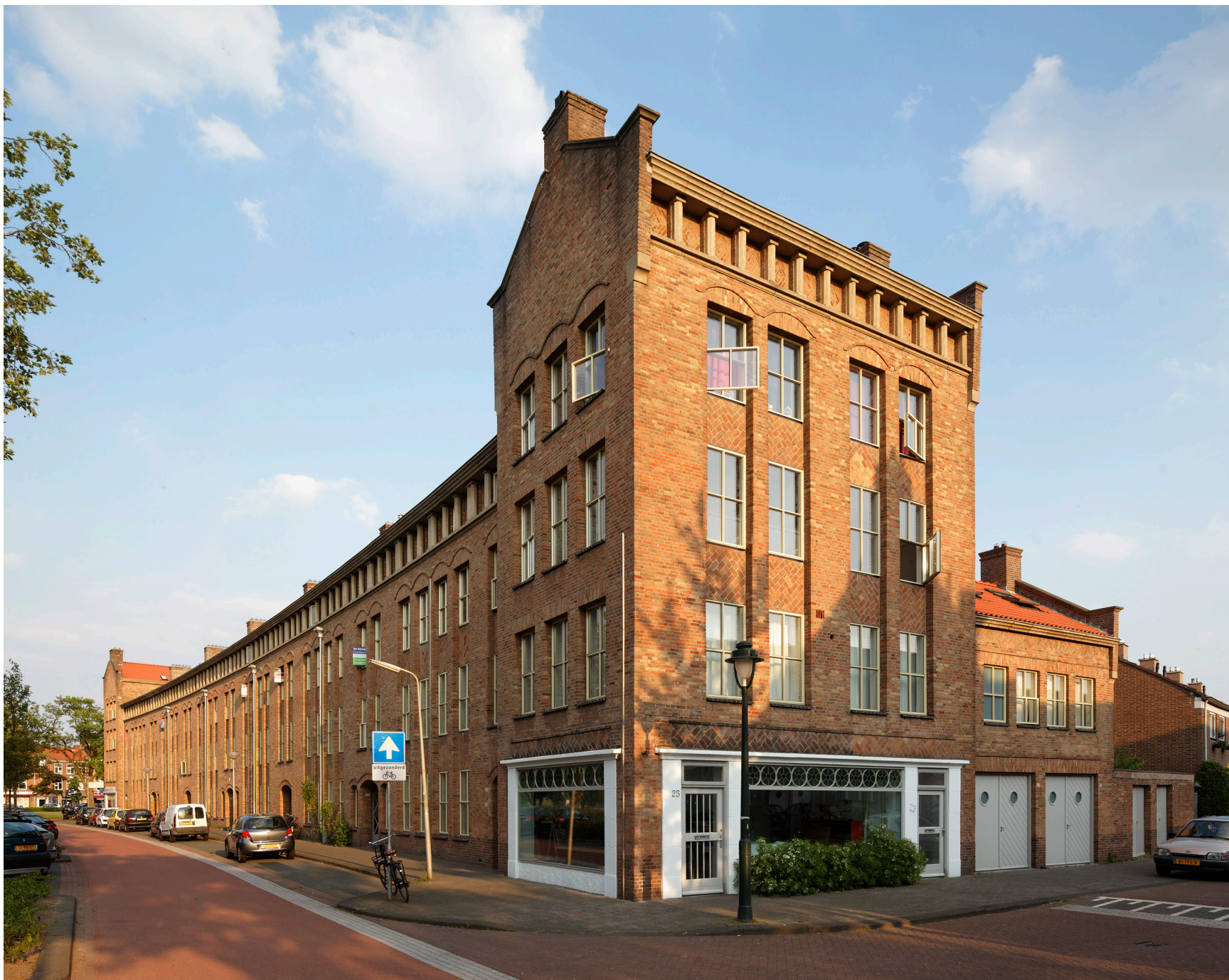
Kop van het blok met winkelruimte in de plint
