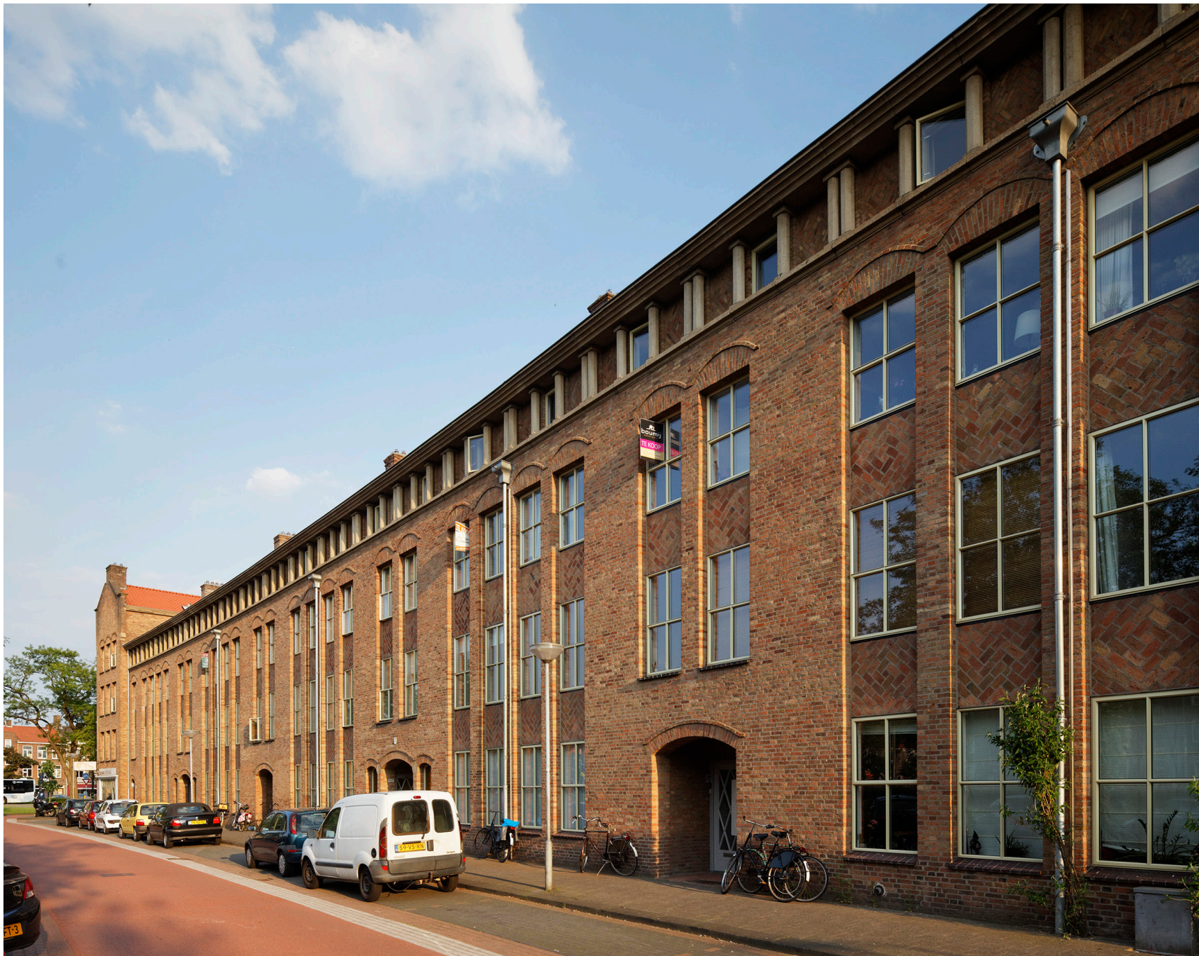
Blik op de gevel parallel aan de Aartshertogenlaan
