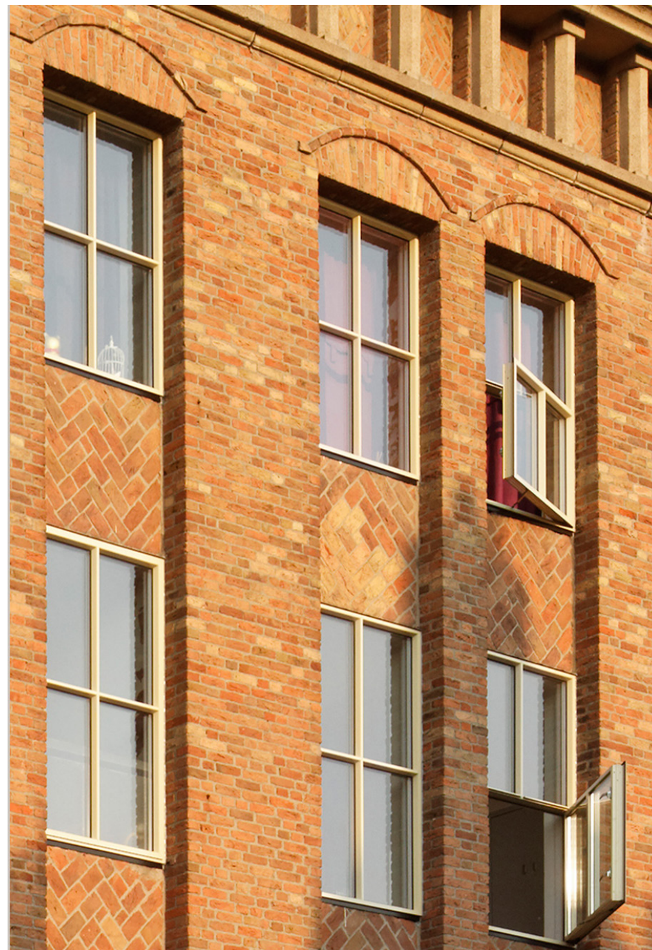
Close up nieuwe kozijnen
