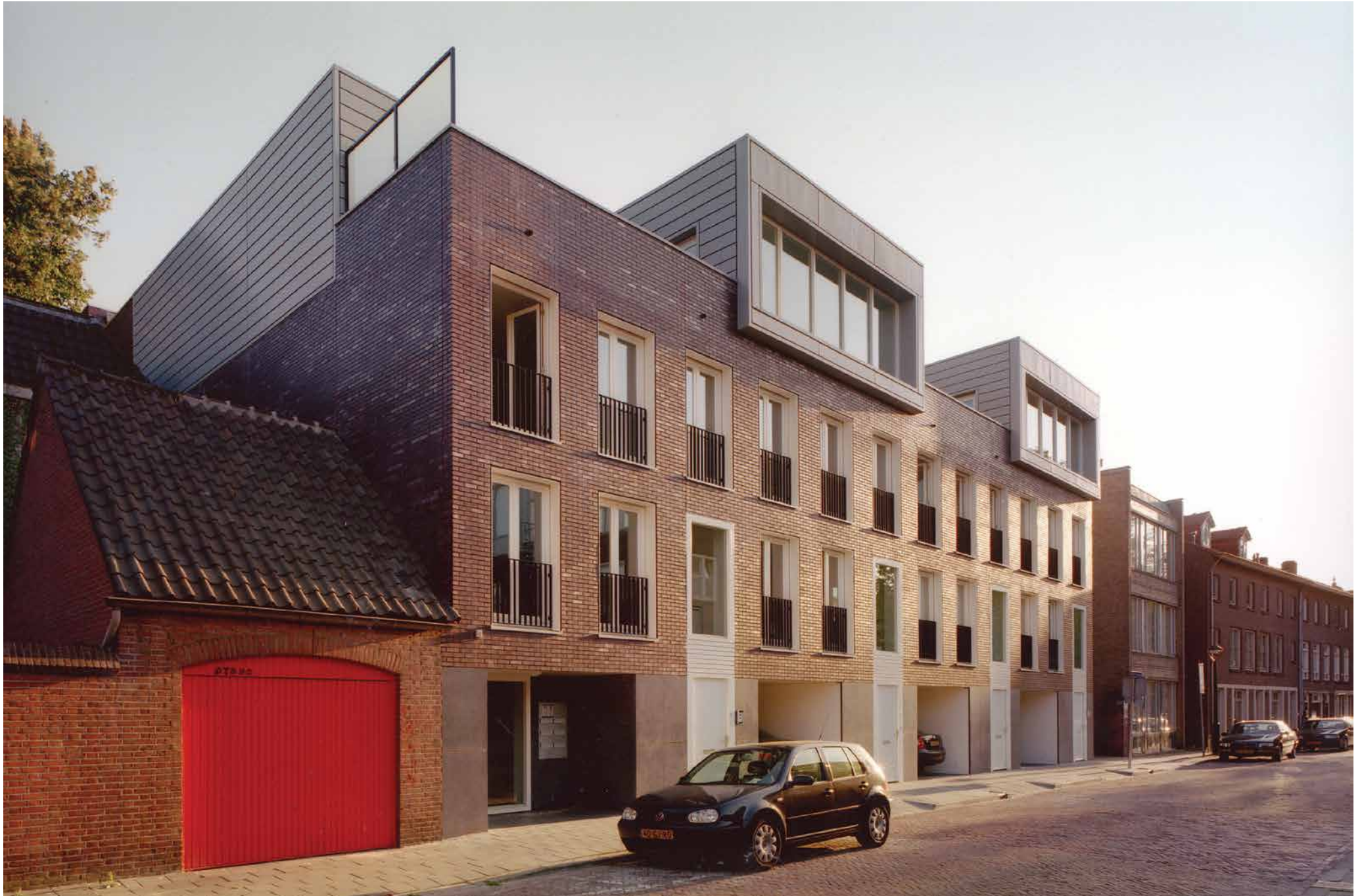
het appartementencomplex met de asymmetrische geplaatste dakwoningen
