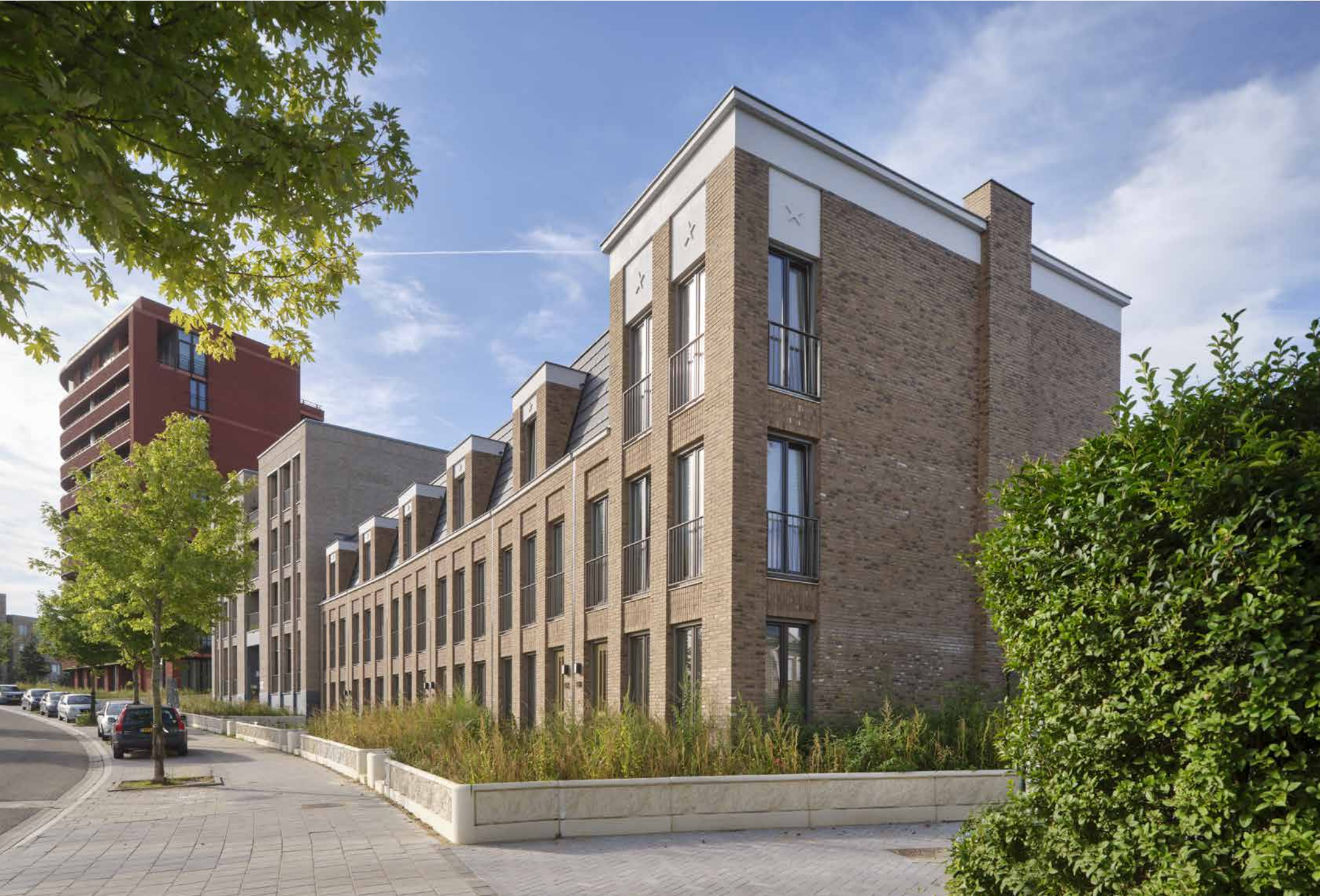
het gebogen blok aan de Kolonel Millerstraat heeft uitzicht op het park bovenop de tunnelentree
